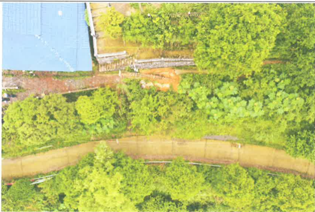
照片2 隐患点俯视图（2024年摄）
