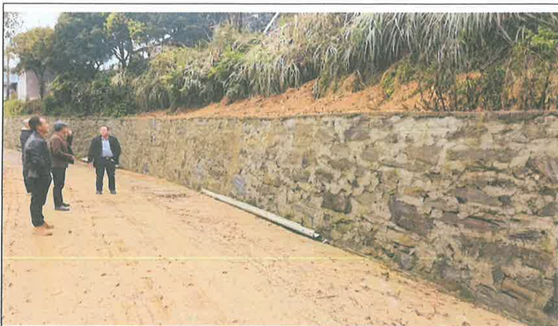
照片11 坡脚挡墙（2025年村里修建）
