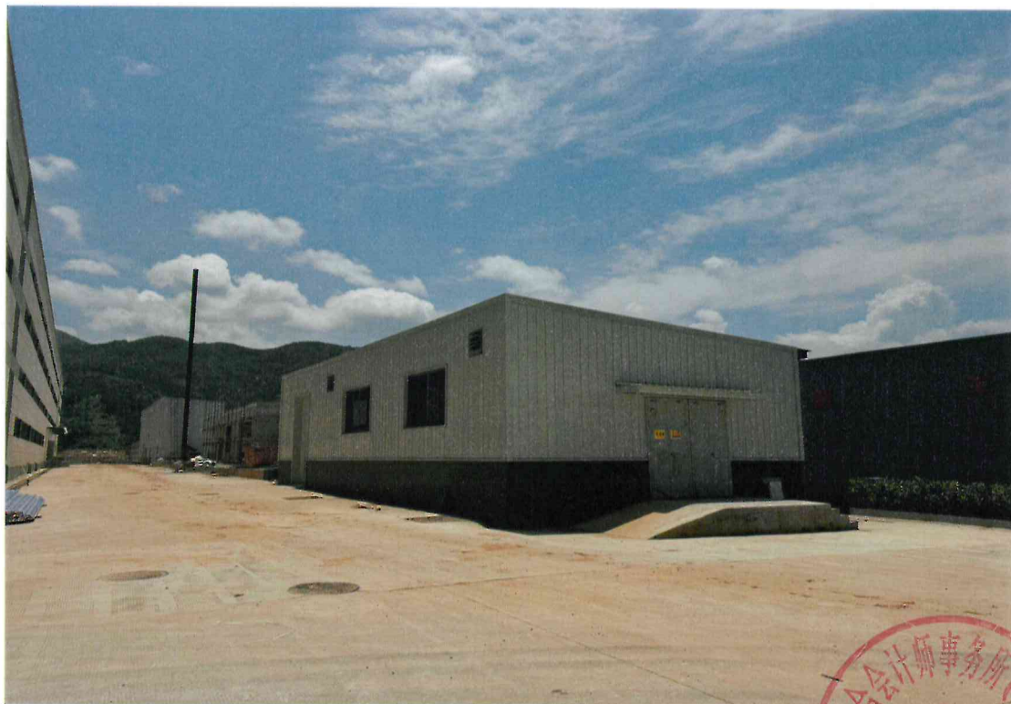
配电房、污水池
