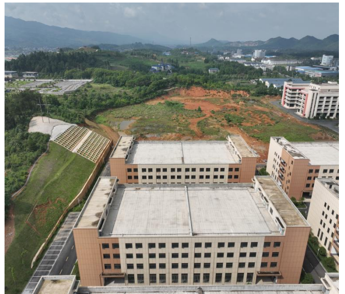
厂房南面现状（闲置厂房）
