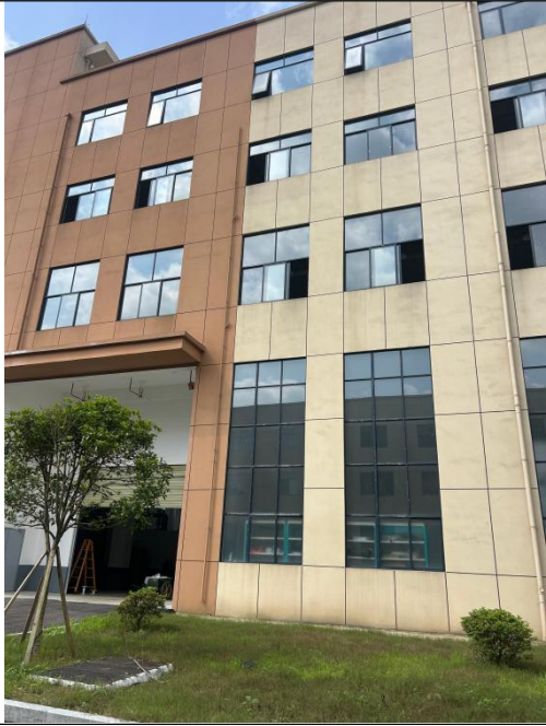
厂房外部现状
