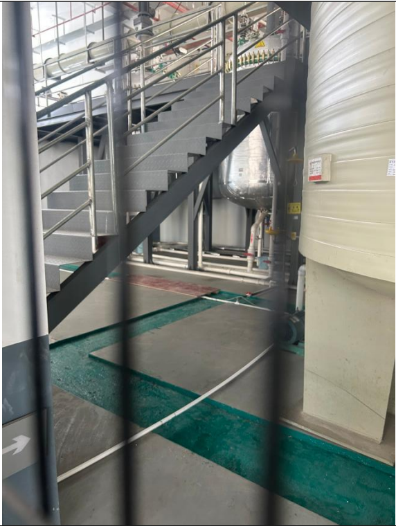
厂房内导流沟
