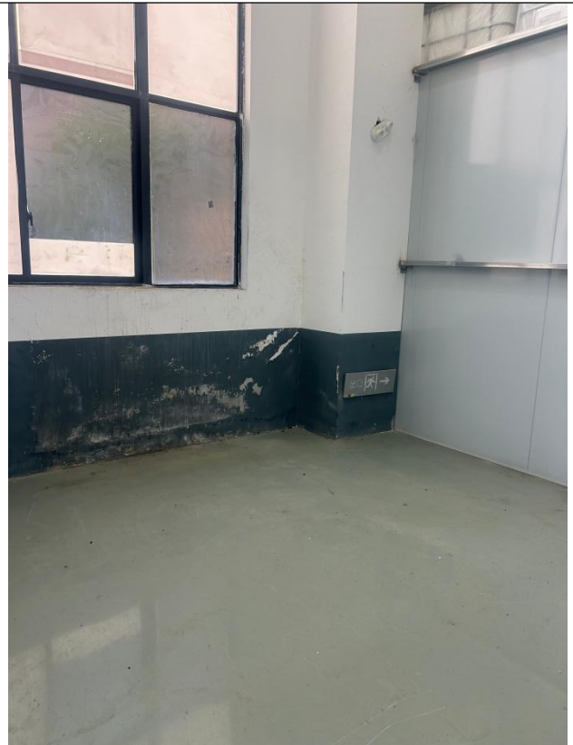
危废暂存间内
